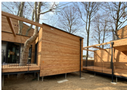
I lodge sono realizzati con il sistema costruttivo prefabbricato in legno (foto Alessandro Romagnoli)
