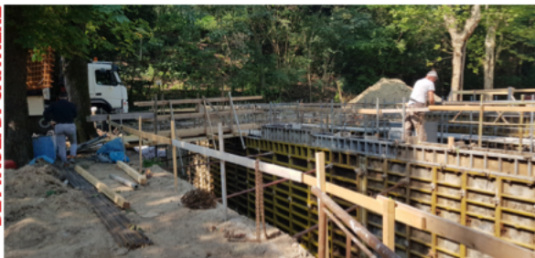
In base alle esigenze strutturali e di destinazione, sono stati previsti plinti gettati in opera o micropali in acciaio, avvitati al terreno e ancorati a travi con profilo a T in acciaio, per gli spazi esterni
