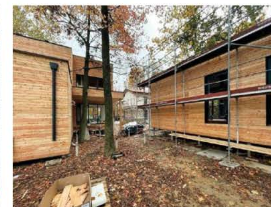
Per preservare l'integrità del bosco non sono stati eseguiti scavi per le fondazioni e non è stata usata la gru per il trasbordo e montaggio degli elementi prefabbricati in legno.
