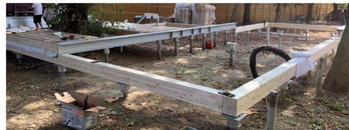
A lato e sotto a destra. Micropali trivellati nel terreno sostengono sia i Lodge che le passerelle di collegamento. I solai in legno degli edifici sono rivestiti, nel lato che volge verso il basso, con pannelli in cemento rinforzato che proteggono dall'umidità del terreno.
