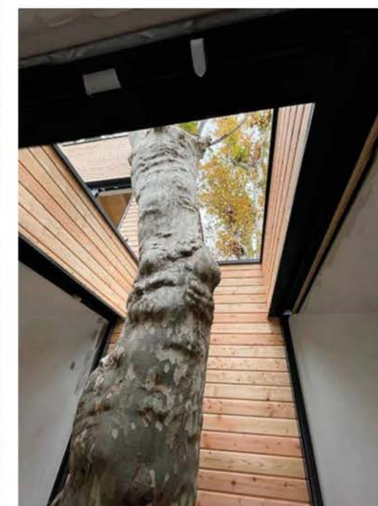
A fianco e a sinistra. Gli alberi ad alto fusto passano attraverso gli edifici e sono visibili dall'interno tramite pareti vetrate con telaio color antracite.
