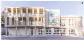
1. LA STRUTTURA. L'Istituto Dottrina Cristiana, situato nel centro storico di L'Aquila, è dotato di un impianto fotovoltaico da 32 kW.
