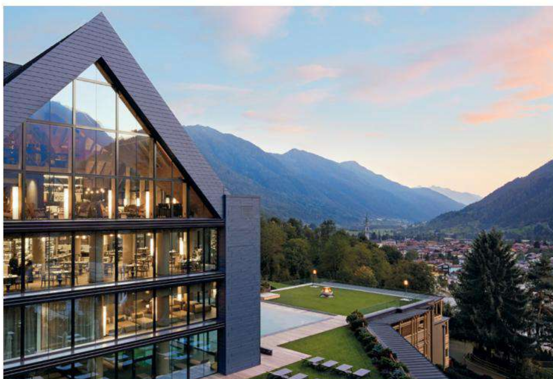
In alto, la lobby d'ingresso all'ultimo piano apre sulla zona lounge (foto ©Mattia Aquila). A fianco, il resort e la Val Rendena sullo sfondo. Nella pagina a fianco, la sky lounge esterna (foto ©Sharon Radisch).
